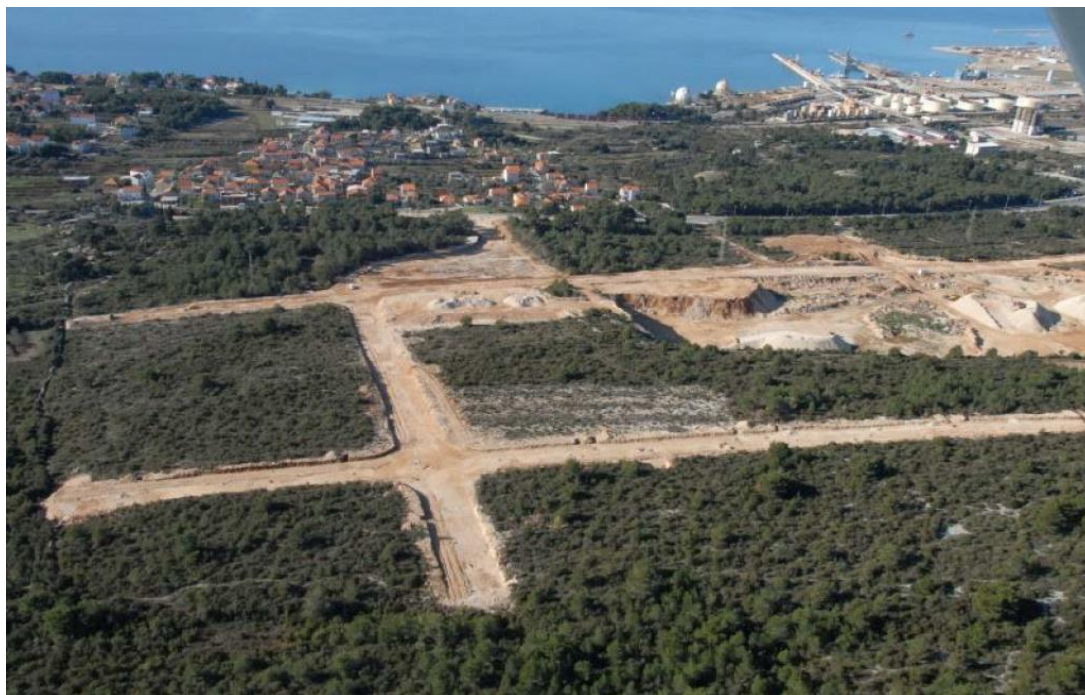
Slika 10. Poslovno-proizvodna zona Lonići, pogled iz zraka Izvor: Općina Bibinje
